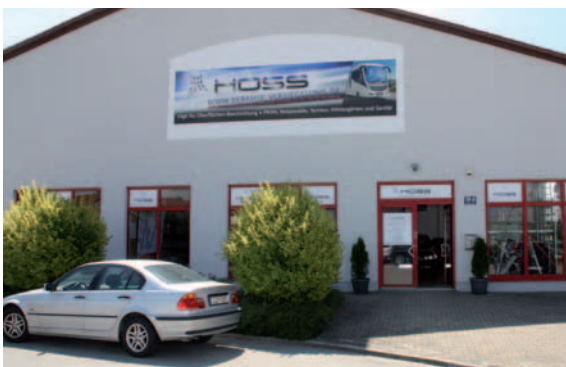
Das Firmengelände befindet sich in Schwabmünchen bei Augsburg. Zurzeit entsteht in wenigen Kilometern Entfernung eine neue, größere Halle.
